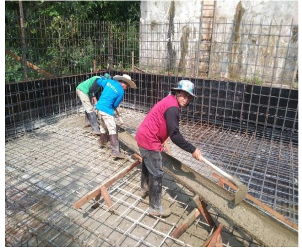
สร้างถังพักน้ำคอนกรีตเสริมเหล็ก ขนาดความจุ ๑๐๐ ลูกบาศก์เมตร
