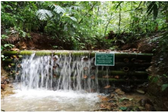
การก่อสร้างฝายต้นน้ำแบบคอกหมู ขนาด ๓ เมตร จำนวน ๒๐ แห่ง
