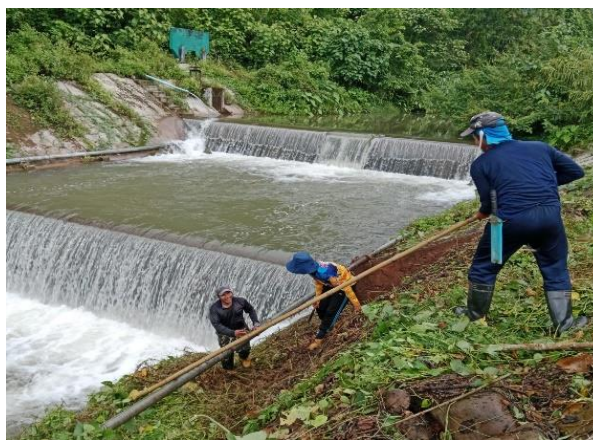
ซ่อมแซมบำรุงรักษาหัวงาน และระบบส่งน้ำฝายน้ำป็น
