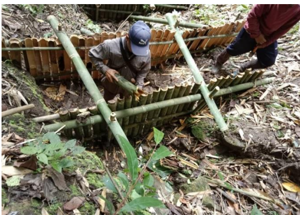
ฝายต้นน้ำแบบคอกหมู
