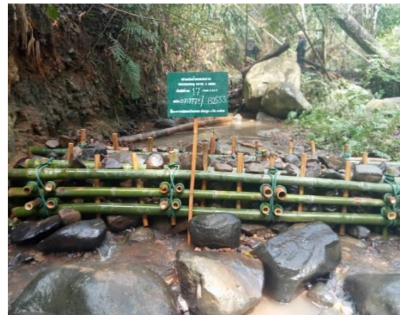
จัดทำฝายต้นน้ำแบบคอกหมู ขนาด ๓ เมตร
