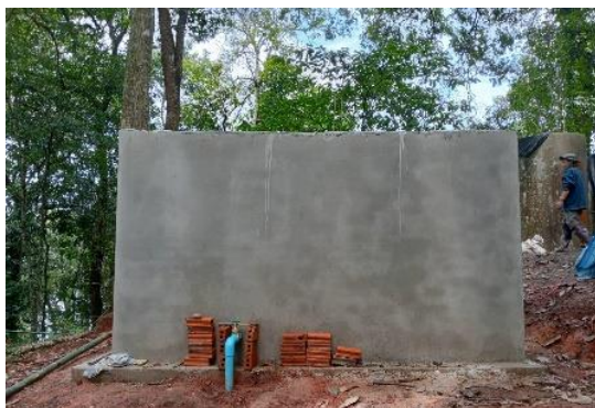
ก่อสร้างถังเก็บน้ำ ขนาด ๕๐ ลูกบาศก์เมตร
