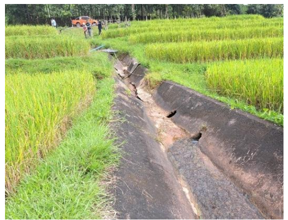
ซ่อมแซมรักษาระบบส่งน้ำฝายสบยอ
