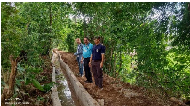
ลำเหมืองคอนกรีตเสริมเหล็กแบบรูปตัวยู
