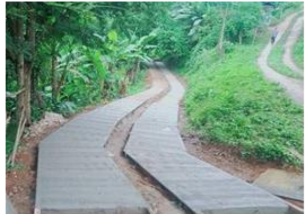
ก่อสร้างถนนสองร่องล้อในเส้นทางคมนาคม ของหมู่บ้าน ระยะทาง ๒๘๐ เมตร
