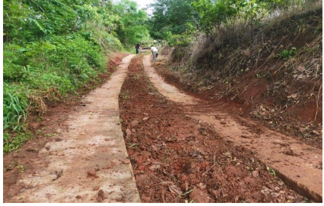
ก่อสร้างถนนคอนกรีตแบบ ๒ ร่องล้อ ระยะทาง ๕๐๐ เมตร
