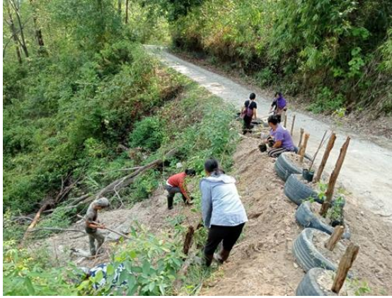
งานซ่อมแซมเส้นทางคมนาคมในหมู่บ้าน
