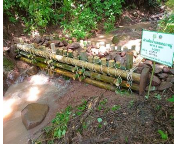
สร้างฝายต้นน้ำแบบคอกหมู ขนาด ๔ เมตร
