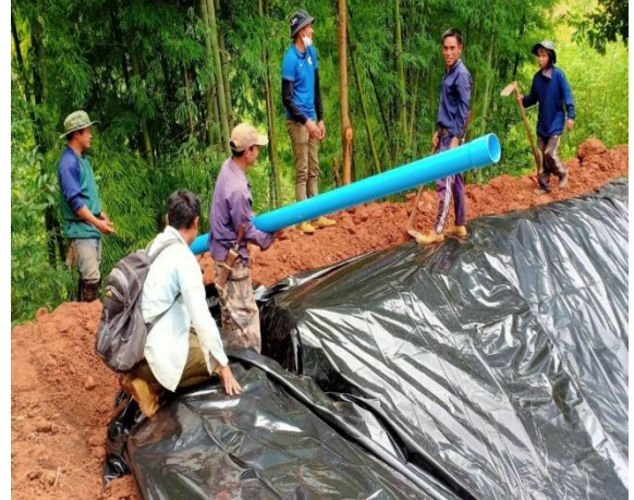
ก่อสร้างบ่อพวงสันเขาและระบบกระจายน้ำ
