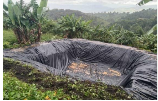
การก่อสร้างบ่อเก็บน้ำ จำนวน ๕ แห่ง
