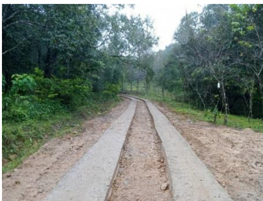
การก่อสร้างถนนคอนกรีตสองร่องล้อ
