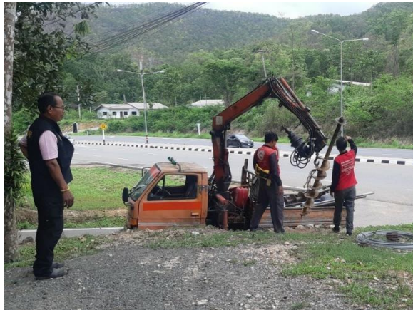
ดำเนินการปรับปรุงระบบไฟฟ้า อาคารสำนักงาน โครงการพัฒนาพื้นที่ ป่าขุนแม่กวงฯ
