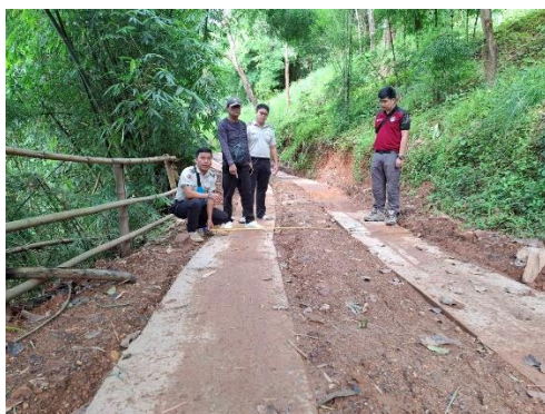
การก่อสร้างถนนคอนกรีตเสริมเหล็ก แบบสองร่องล้อ ระยะทาง ๓๐๐ เมตร
