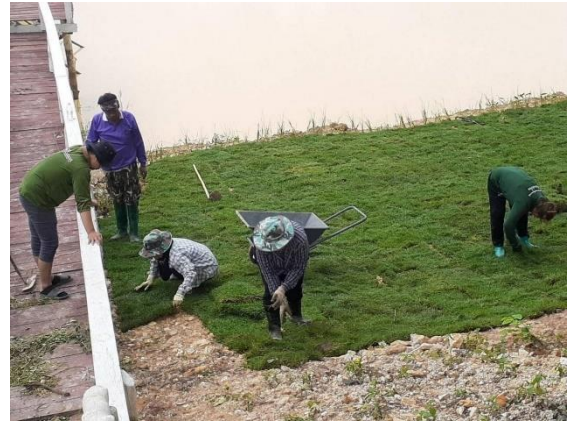
ดำเนินการปรับปรุงภูมิทัศน์บริเวณโดยรอบ โครงการพัฒนาพื้นที่ห้วยลานฯ
