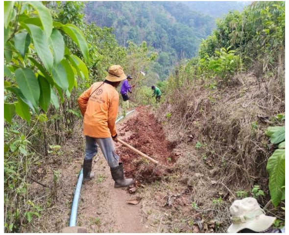
ติดตั้งระบบกระจายน้ำโครงการฝายห้วย ชวากพร้อมระบบส่งน้ำ
