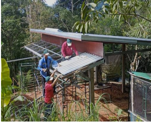
ซ่อมแซมต่อเติมห้องเก็บวัสดุ อุปกรณ์
