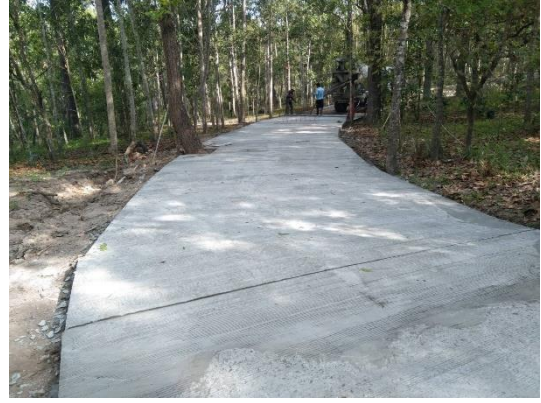
ซุ้มชมถนนบริเวณอาคารที่ทำการ ระยะที่ ๓ ระยะทาง ๔๕๕ เมตร
