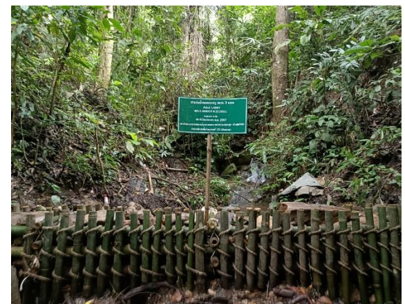
ฝายต้นน้ำแบบคอกหมูขนาด ๓ เมตร
