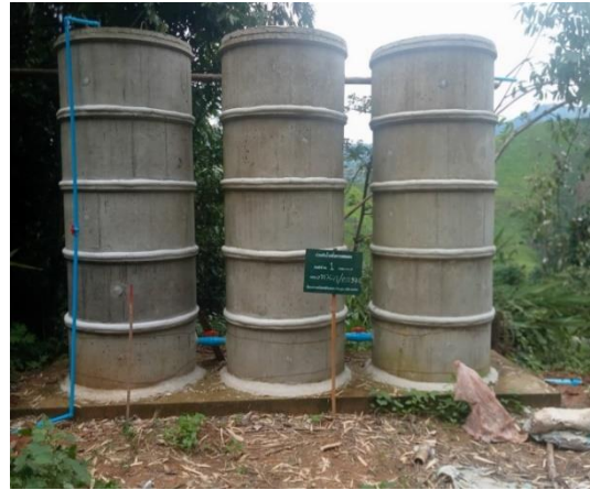
ก่อสร้างถังพักน้ำ ขนาด ๖ ลบ.ม.
