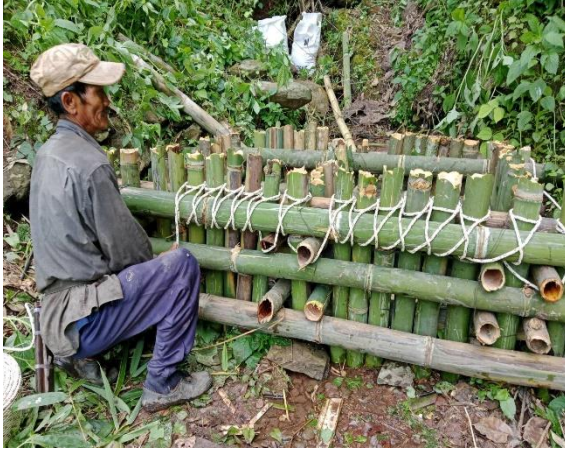
สร้างฝายต้นน้ำแบบคอกหมู ขนาด ๓ เมตร
