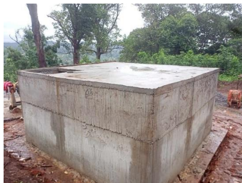
บ่อเก็บพักน้ำคอนกรีต
