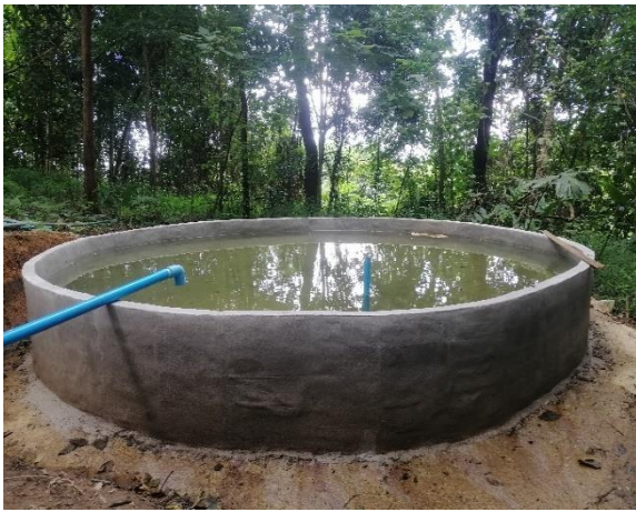
สร้างบ่อพักน้ำเพื่อการเกษตร
