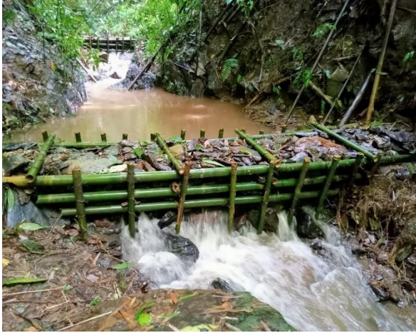
ฝายต้นน้ำแบบคอกหมู ขนาด ๓ เมตร
