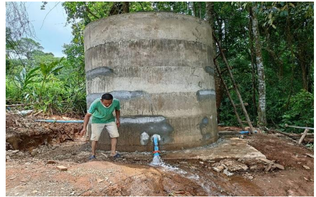
ขณะดำเนินการก่อสร้างบ่อเก็บน้ำคอนกรีตเสริมเหล็ก และก่อสร้างถังกรองน้ำ
