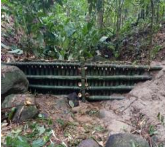
จัดทำฝายต้นน้ำแบบคอกหมู ขนาด ๓ เมตร
