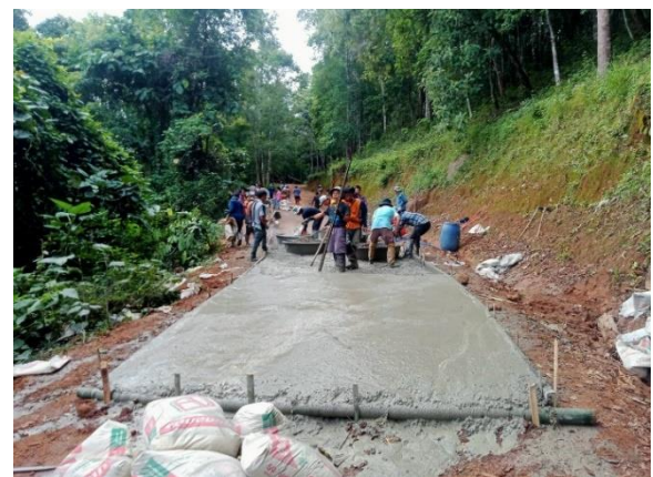
ปรับปรุงถนนคอนกรีตเสริมเหล็ก
