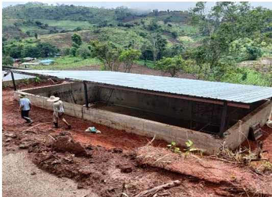
ขณะดำเนินการก่อสร้างบ่อเก็บน้ำคอนกรีตเสริมเหล็ก และก่อสร้างถังกรองน้ำ
