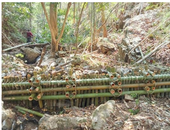
การก่อสร้างฝายต้นน้ำแบบคอกหมู ขนาด ๔ เมตร จำนวน ๔๐ แห่ง
