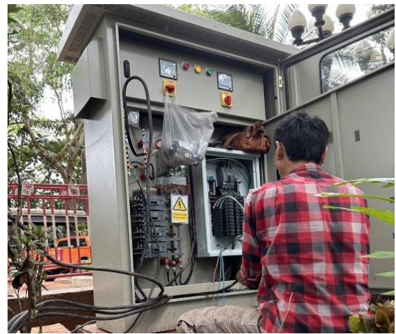
ซ่อมแซมบำรุงรักษาระบบไฟฟ้า อาคารพระตำหนัก
