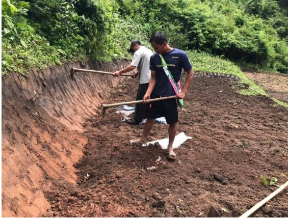
กิจกรรมอนุรักษ์ดินและน้ำแบบขั้นบันได ด้วยการทำขั้นบันได จำนวน ๓๐ ไไร่
