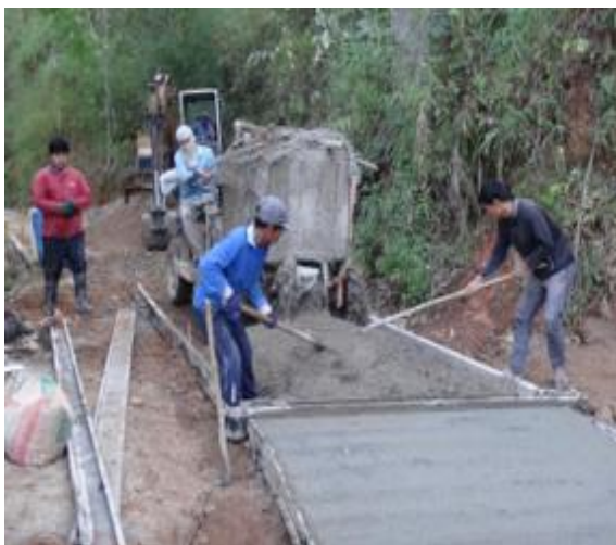
ก่อสร้างถนนคอนกรีตเสริมเหล็ก ขนาดกว้าง ๓ เมตร
