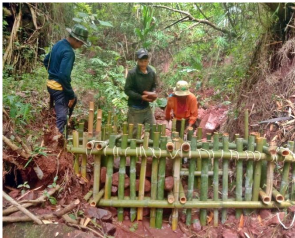
สร้างฝายต้นน้ำแบบคอกหมู ขนาด ๓ เมตร
