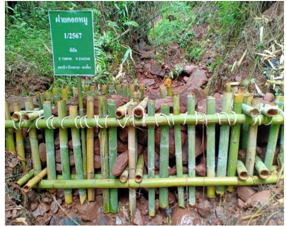
จัดทำฝายต้นน้ำแบบคอกหมู ขนาด ๔ เมตร
