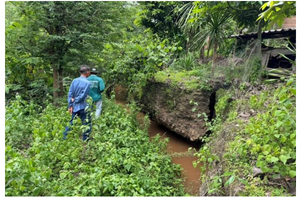
บริเวณแนวท่อส่งน้ำ ที่จะดำเนินการก่อสร้าง
