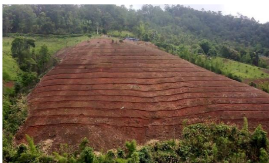
การอนุรักษ์ดินและน้ำแบบขั้นบันได (นาแลกป่า)
