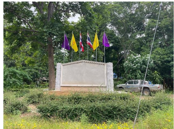
ก่อสร้างป้ายโครงการพัฒนาเบ็ดเสร็จลุ่มน้ำสาขาแม่น้ำปิงอันเนื่องมาจากพระราชดำริ
