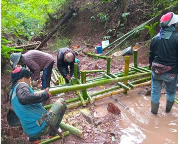
สร้างฝายต้นน้ำแบบคอกหมู ขนาด ๔ เมตร
