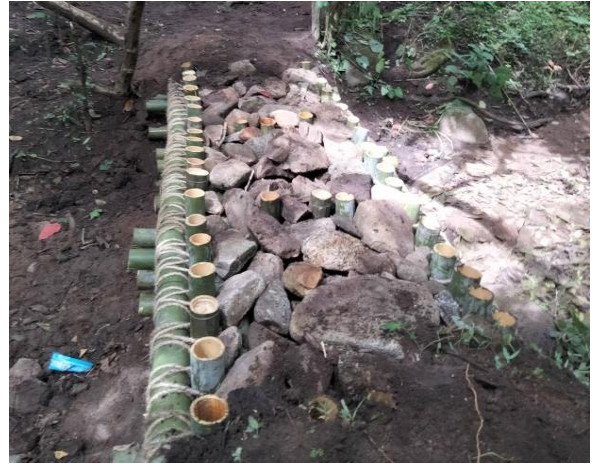
ฝายต้นน้ำแบบคอกหมู
