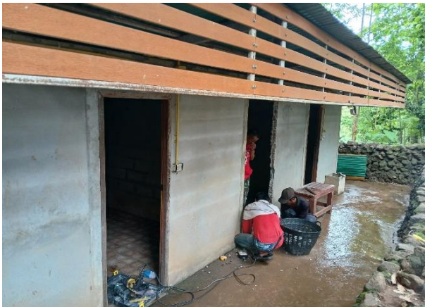
งานปรับปรุงซ่อมแซม
