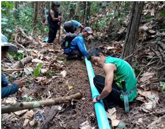
การซ่อมแซมระบบกระจายน้ำ
