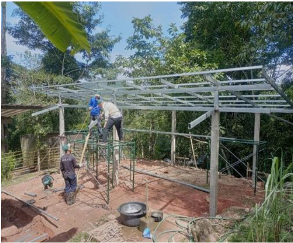
ซ่อมแซมบำรุงรักษาอาคารชลประทาน
