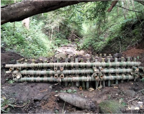
ฝายต้นน้ำแบบคอกหมู
