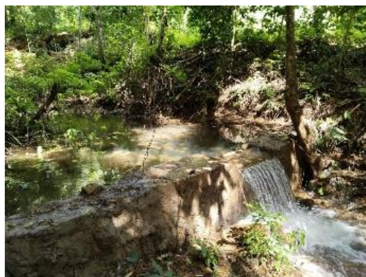
ดำเนินการสร้างฝายชะลอน้ำ เพื่อการฟื้นฟูระบบนิเวศ
