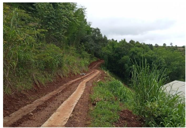
การก่อสร้างถนนคอนกรีตเสริมเหล็กแบบสองร่องล้อ ระยะทาง ๕๐๐ เมตร
