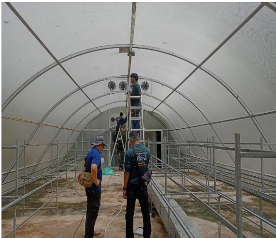
ซ่อมแซมบำรุงรักษาโรงอบพลังงาน แสงอาทิตย์
