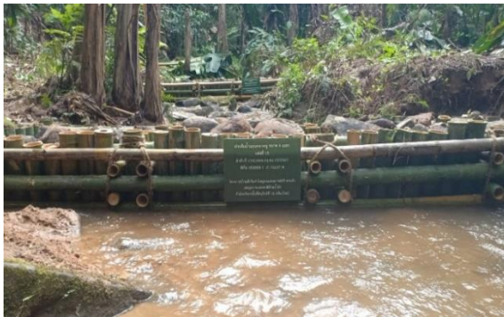
การก่อสร้างฝายต้นน้ำแบบคอกหมู ขนาด ๔ เมตร จำนวน ๒๐ แห่ง
