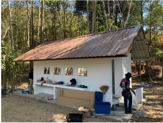
ดำเนินการก่อสร้างห้องน้ำ โครงการพัฒนาพื้นที่ห้วยลานอันเนื่องมาจากพระราชดำริ
