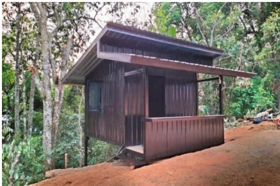
การก่อสร้างจุดสกัดป่าข้าวหลาม
