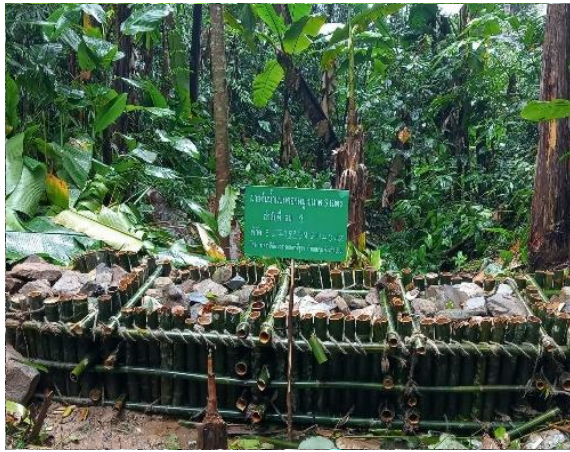
ฝายต้นน้ำแบบคอกหมูขนาด ๓ เมตร
