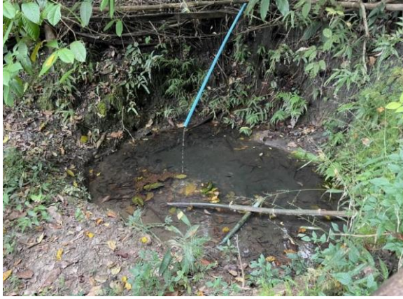
บริเวณจุดก่อสร้างฝายต้นน้ำบ้านแม่ลง
