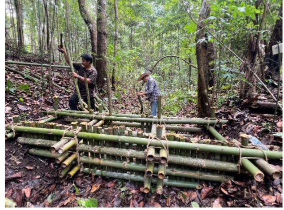
การก่อสร้างฝายต้นน้ำแบบคอกหมู ขนาด ๓ เมตร จำนวน ๒๐ แห่ง
