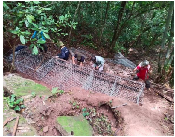
ซ่อมแซมบำรุงรักษาระบบส่งน้ำฝายสบยอ
