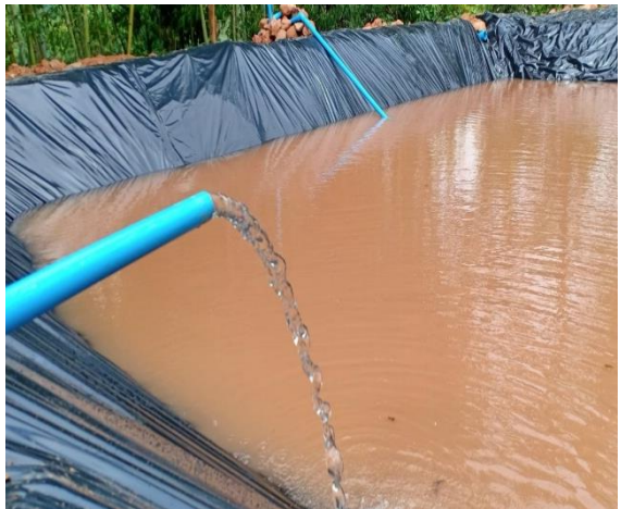
จัดทำระบบกระจายน้ำเพื่อการเกษตร
