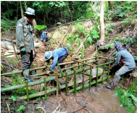
ก่อสร้างฝายต้นน้ำแบบคอกหมู ขนาด ๓ เมตร
