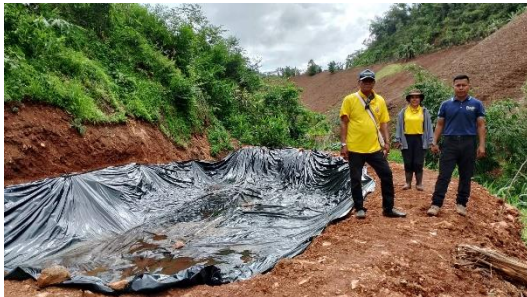
การก่อสร้างบ่อพักน้ำเพื่อการเกษตร (บ่อพวง)
