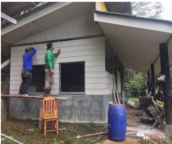
ซ่อมแซมอาคารสิ่งปลูกสร้างในโครงการฯ
