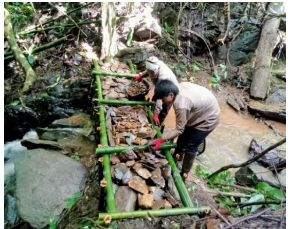
ก่อสร้างฝายต้นน้ำแบบคอกหมู ขนาด ๓ เมตร
