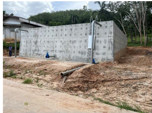
ถังเก็บน้ำ ขนาด ๕๐๐ ลูกบาศก์เมตร
