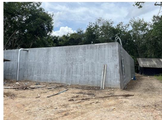
ถังเก็บน้ำ ขนาด ๑,๖๐๐ ลูกบาศก์เมตร
