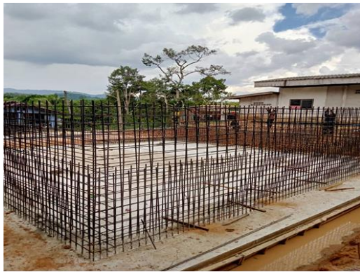
ถังเก็บน้ำ ขนาด ๕๐๐ ลูกบาศก์เมตร
