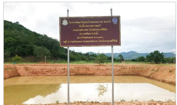
สระน้ำ ขนาดกว้าง ๔๐ เมตร ยาว ๔๐ เมตร ลึก ๔ เมตร ความจุ ๖,๔๐๐ ลูกบาศก์เมตร
