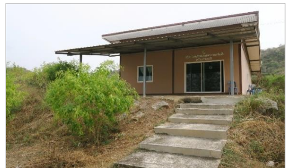
สำนักงานโครงการฯ พร้อมระบบน้ำและระบบไฟ
